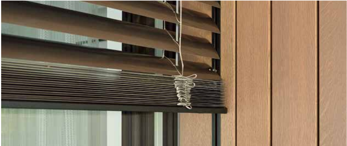
Führungsschiene in der Laibung
